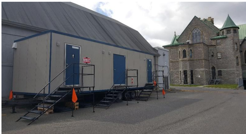
Installation du prototype au Cégep de Saint-Laurent en 2017
